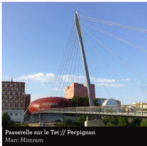
© photo : Eiffage Métal
