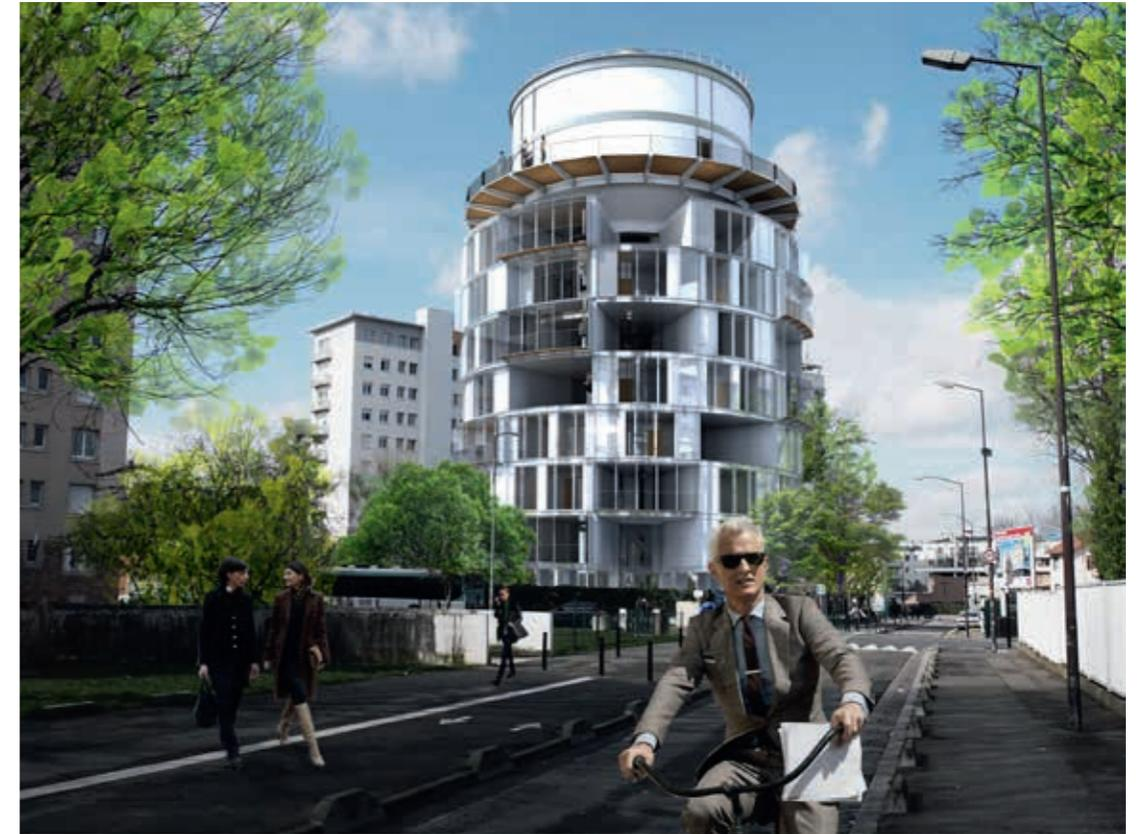
« Le rapport élevé résistance/poids de l'acier confère à la structure additionnelle sa légèreté et minimise ainsi les risques liés à l'augmentation des charges sur le château d'eau. »
