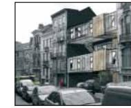
181 Olivia Cocagne École d'architecture de Paris-Malaquais Marwen Feriani École d'architecture de Paris-la-Villette Julien Deloffre École d'architecture de Bordeaux
