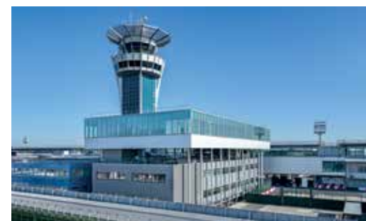
EXTENSION DU CENTRE DE CONTRÔLE AÉRIEN D'ORLY PARAY-VIEILLE-POSTE, 2022
