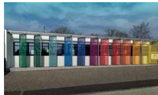
EXTENSION DU GROUPE SCOLAIRE DE ARVERT ARVERT, 2022
