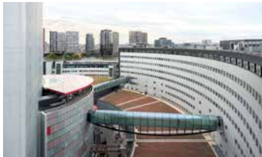
PASSERELLES MAISON DE LA RADIO ET DE LA MUSIQUE PARIS, 2022
