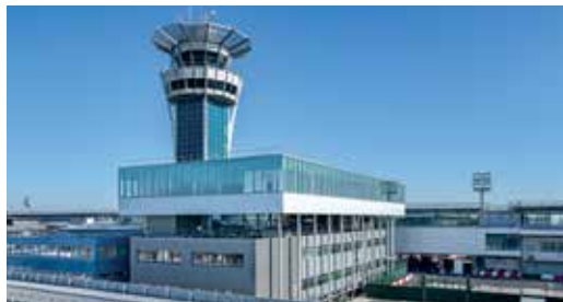
EXTENSION DU CENTRE DE CONTRÔLE AÉRIEN D'ORLY PARAY-VIEILLE-POSTE, 2022
