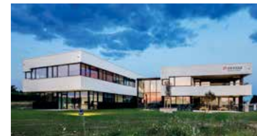
CONSTRUCTION DES BUREAUX ET ATELIERS EIFFAGE ENERGIE SYSTÈMES POITOU-CHARENTES SAINT-JEAN-D'ANGÉLY, 2022
