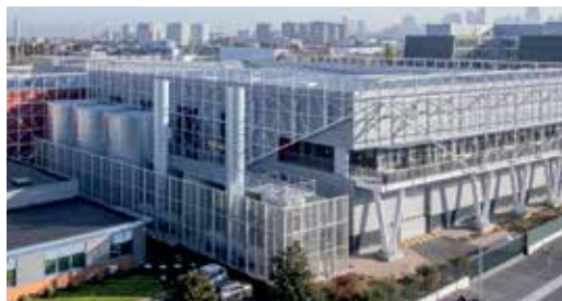
RESTRUCTURATION DU CENTRE DE TRI DE COLLECTE SÉLECTIVE DU SYCTOM À NANTERRE, 2021
