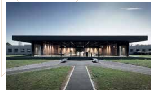
EXTENSION DU CRNA REIMS, 2022
