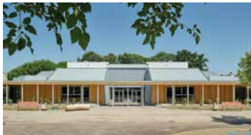
RÉNOVATION THERMIQUE DE L'ÉCOLE JACQUES GILBERT-COLLET - CHEVILLY-LARUE, 2022
