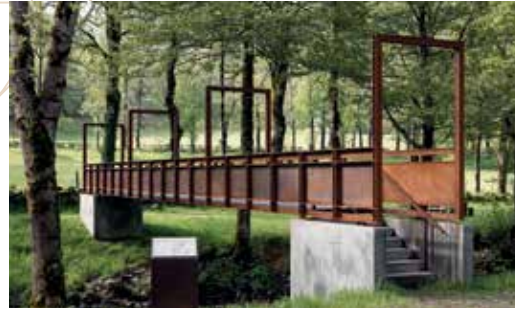
PASSERELLE PIÉTONNE AU-DESSUS DE LA JORDANNE À MANDAILLES SAINT-JULIEN, 2022
