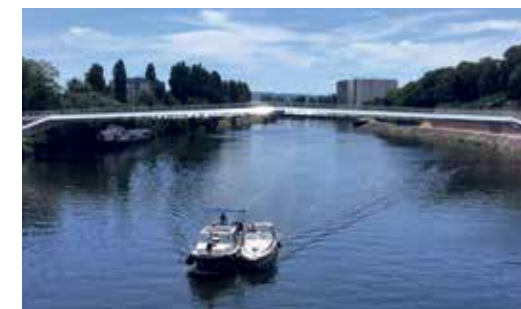
PASSERELLE DE L'EUROPE THONVILLE, 2021
