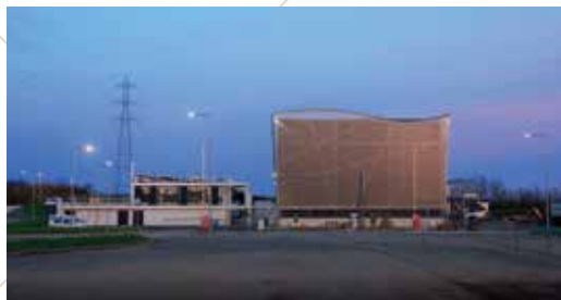
CONSTRUCTION D'UN CENTRE TECHNIQUE AU VALLON D'ARTY - NIORT, 2021
