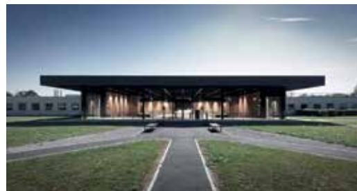
EXTENSION DU CRNA REIMS, 2022
